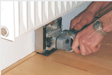
Řezání dilatačních spár pod radiátory
